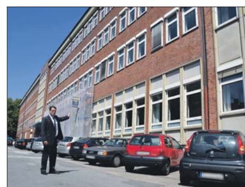
Auf vier Etagen an der Humboldtstraße soll im August das Berufsbildungswerk in das ehemalige Gebäude der Stadtwerke Kiel einziehen. Immobilienberater Tim Staub (li.) ist für die Vermarktung zuständig. Foto Haese
